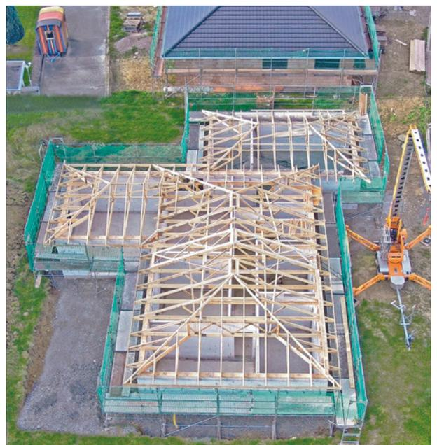
Die **NailCon®**- Nagelplattenbinder erlauben Tragwerksplanern und Architekten den Spagat zwischen Schnelligkeit und Effizienz beim Bauen.
